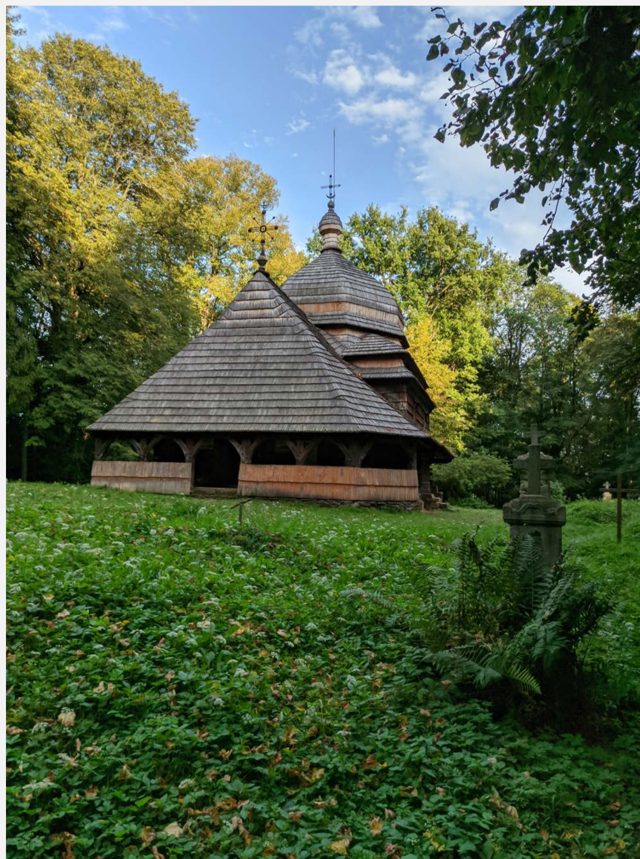
Cerkiew w Uluczu od strony wejścia
